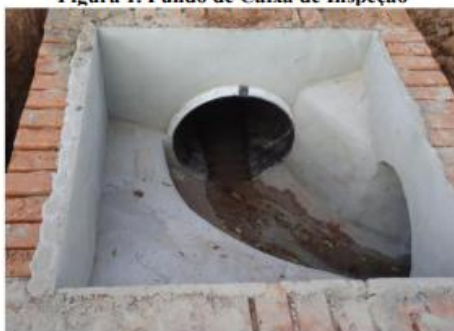
Figura 1. Fundo de Caixa de Inspeção
