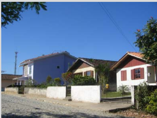
Figura 153: FOTO DE HABITAÇÕES NO BAIRRO CENTRO
