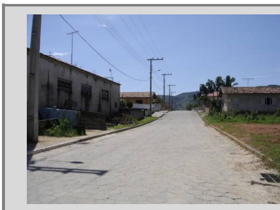
Figura 132: FOTO DO PAVIMENTO DA RUA SEVERO COSTA
