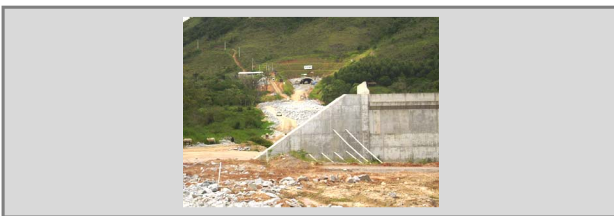
Figura 134: VISTA DO TÚNEL, AO FUNDO, E PASSAGEM INFERIOR CONCLUÍDA, SEM O ATERRO Fonte: CONSÓRCIO HARDT-ENGEMIN (2008)
