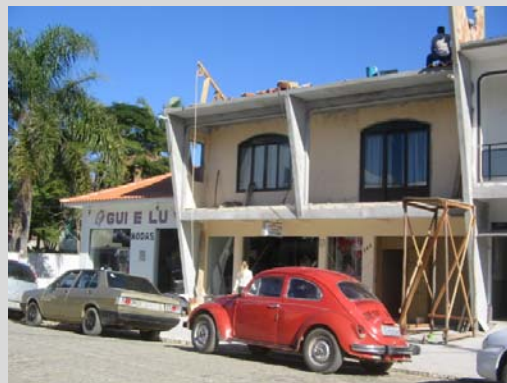
Figura 154: FOTO DE HABITAÇÕES, RUA SANTA CATARINA, CENTRO.
