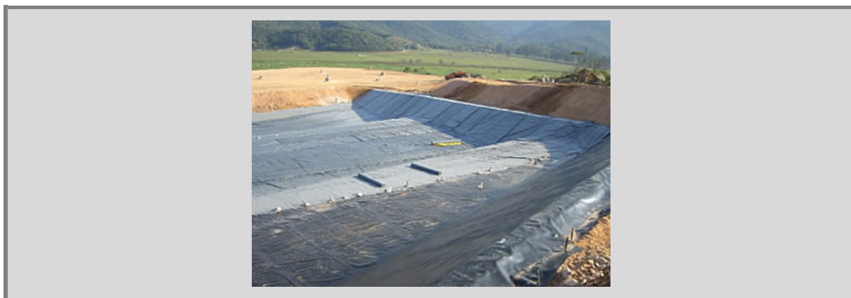
Figura 139: FOTO DO ATERRO SANITÁRIO DA PROACTIVA EM BIGUAÇU
