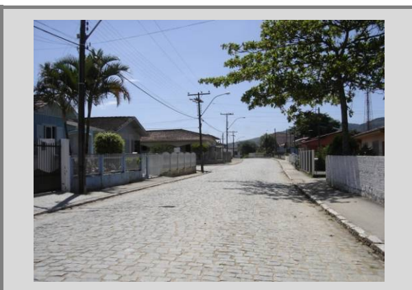
Figura 133: FOTO DO PAVIMENTO DA RUA JOÃO DE SOUZA COORDENADAS UTM:
