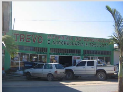
Figura 118: FOTO DE UM ESTABELECIMENTO COMERCIAL - MATERIAIS DE CONSTRUÇÃO E AGROPECUÁRIA. RUA FLORIANÓPOLIS, CENTRO Fonte: CONSÓRCIO HARDT-ENGEMIN (2009)
