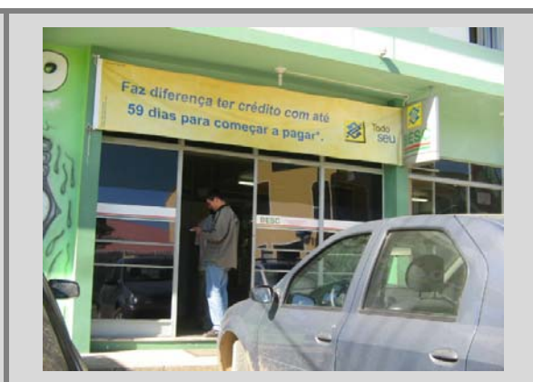
Figura 122: FOTO DE UMA AGÊNCIA BANCÁRIA (BANCO DO BRASIL). RUA FLORIANÓPOLIS, CENTRO Fonte: CONSÓRCIO HARDT-ENGEMIN (2009)
