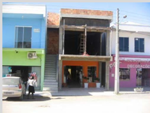
Figura 156: FOTO DE HABITAÇÕES RECENTES COM MAIS DE UM PAVIMENTO, CENTRO
