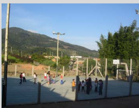
Figura 184: FOTO DA QUADRA DE ESPORTES DA ESCOLA BÁSICA DR. IVO SILVEIRA. NECESSITA MANUTENÇÃO
