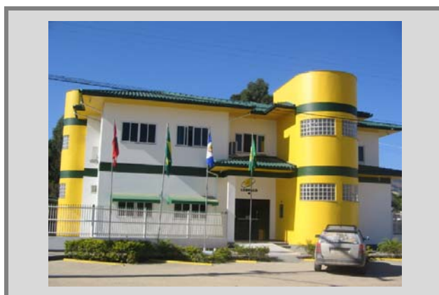
Figura 121: FOTO DA COOPERATIVA DE ELETRICIDADE DE PAULO LOPES (CERPALO), CENTRO Fonte: CONSÓRCIO HARDT-ENGEMIN (2009)
