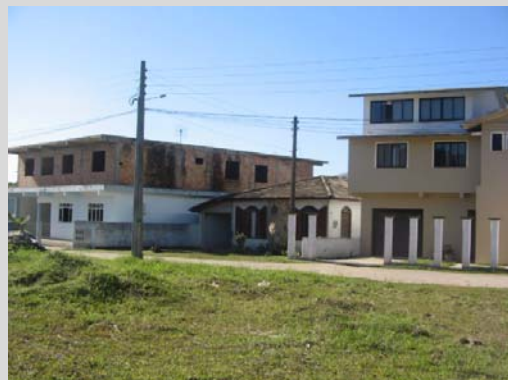
Figura 158: FOTO DE HABITAÇÕES RECENTES COM MAIS DE UM PAVIMENTO, CENTRO
