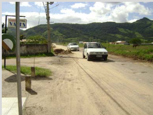
Figura 137: RUA TOBIAS RAUPP DE SÁ, BAIRRO AREIAS
