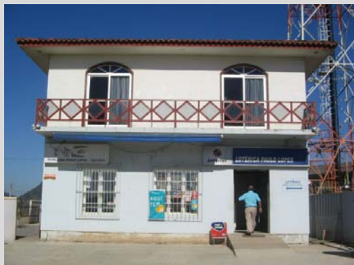
Figura 157:: FOTO DE HABITAÇÕES COM MAIS DE UM PAVIMENTO, CENTRO
