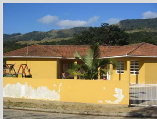
Figura 171: FOTO DA ESCOLA ISOLADA DE MORRO AGUDO
