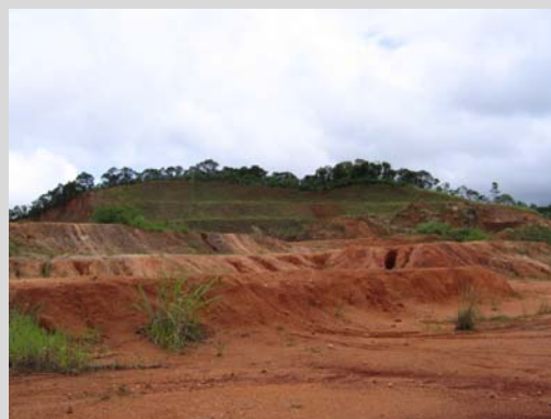
Figura 60: EROSÃO EM CAIXA DE EMPRÉSTIMO EM RECUPERAÇÃO (PONTO 02)
