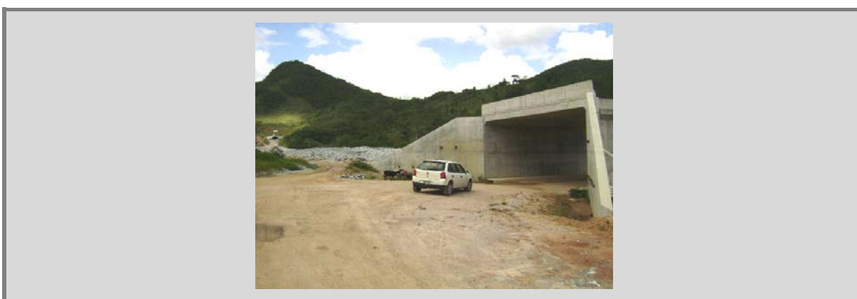
Figura 135: VISTA DA PASSAGEM INFERIOR CONCLUÍDA (FLUXO URBANO), COM TÚNEL AO FUNDO. Fonte: CONSÓRCIO HARDT-ENGEMIN (2008)
