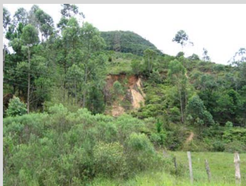
Figura 61: EROSÃO EM ENCOSTA (PONTO 03)
