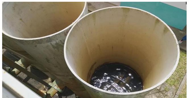
Figura 20: ETA - Tanques de contato.
