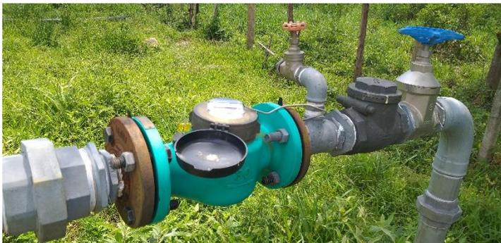
**Figura 41: Poço do Morro Agudo – Macromedidor de vazões.**
