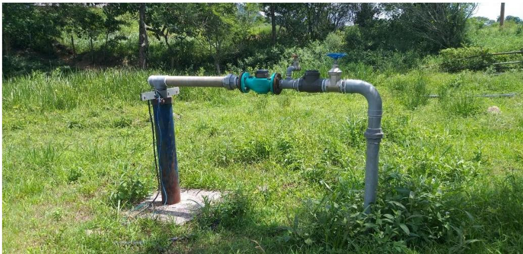
**Figura 40: Poço do Morro Agudo – Macromedidor e Acessórios de controle.**
