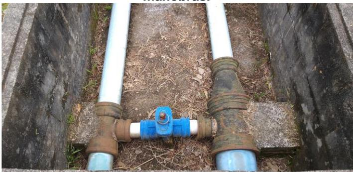
Figura 50: Reservatórios SAA Central – válvulas e registros de controle.
