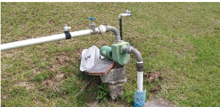
Figura 93: SAA Sorocaba - ponteira típica.
