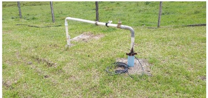
Figura 92: SAA Sorocaba - ponteira típica.
