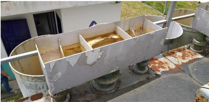
Figura 17: ETA - Caixas de distribuição de água decantada.
