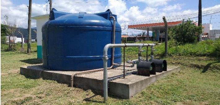
Figura 64: SAA Areias - Conjunto moto bombas do recalque à ETA.
