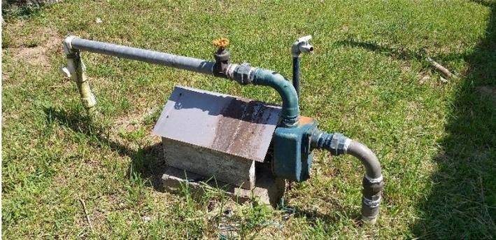
Figura 106: SAA Gamboa - Ponteira típica.
