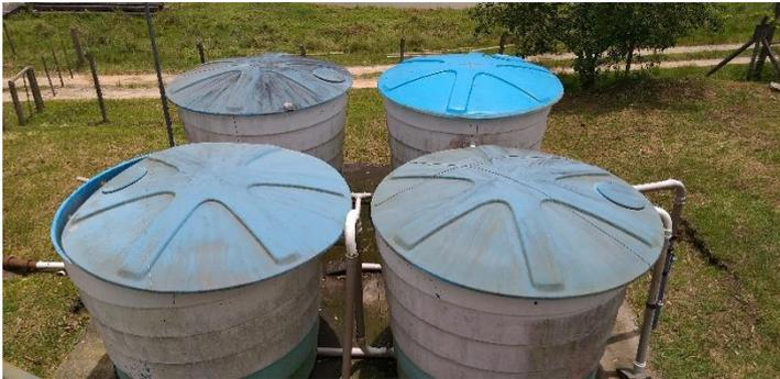
Figura 21: ETA - Tanques de contato.
