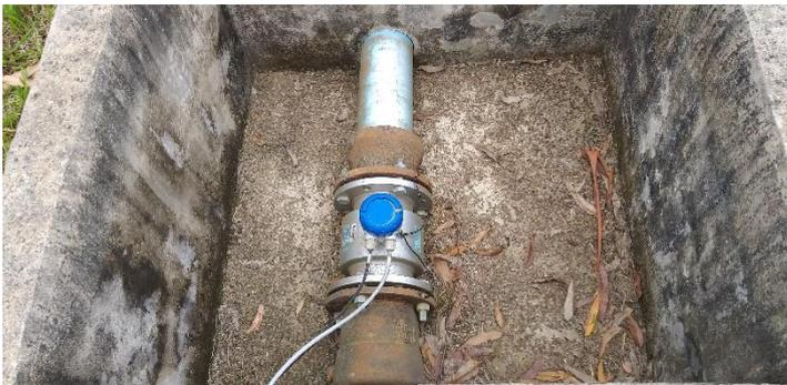
Figura 52: Macromedidor ultrassônico - display de leitura.
