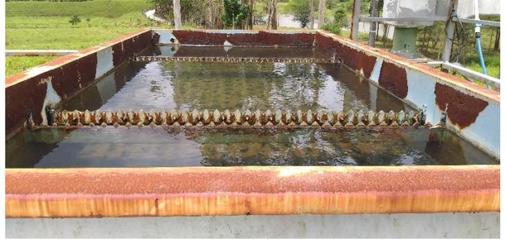
Figura 16: ETA - Caixas de distribuição de água decantada.
